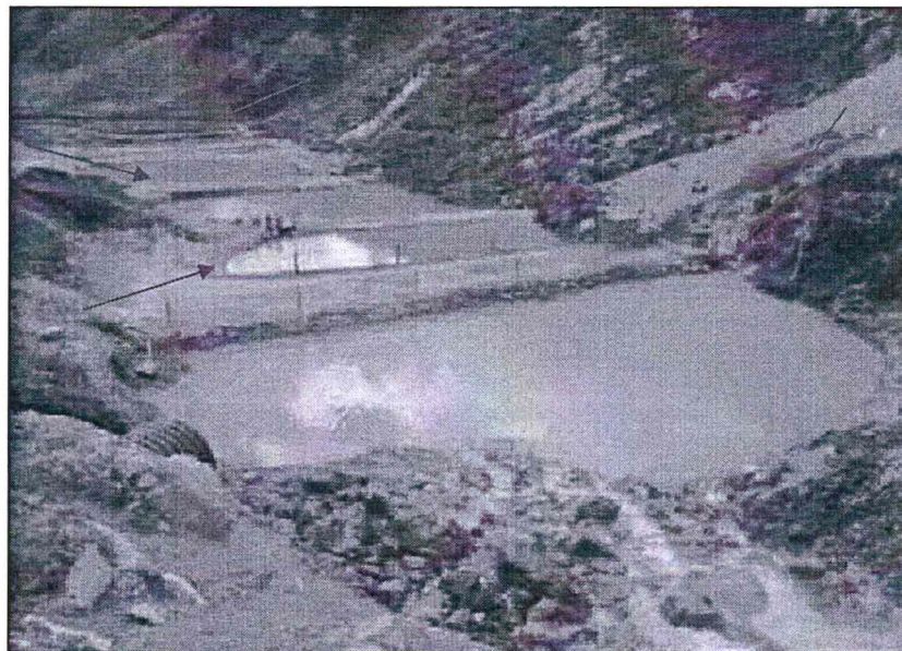
Fotografía N° 20.- Vista de la planta de tratamiento de aguas de mina desde el Nivel 0.
