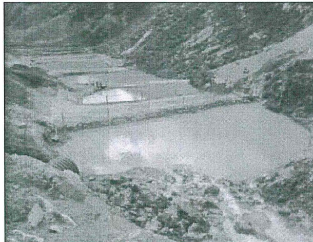
Fotografía N° 20.- Vista de la planta de tratamiento de aguas de mina desde el Nivel 0.
