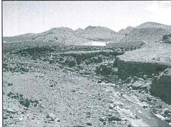
Fotografía 18: Fuerte erosión producida por el reboce del aliviadero.
