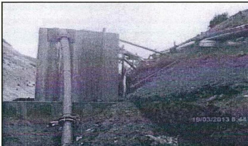
Fotografía N° 04. Se verificó el cajón rompe presión operativo con la base limpia de relaves.
