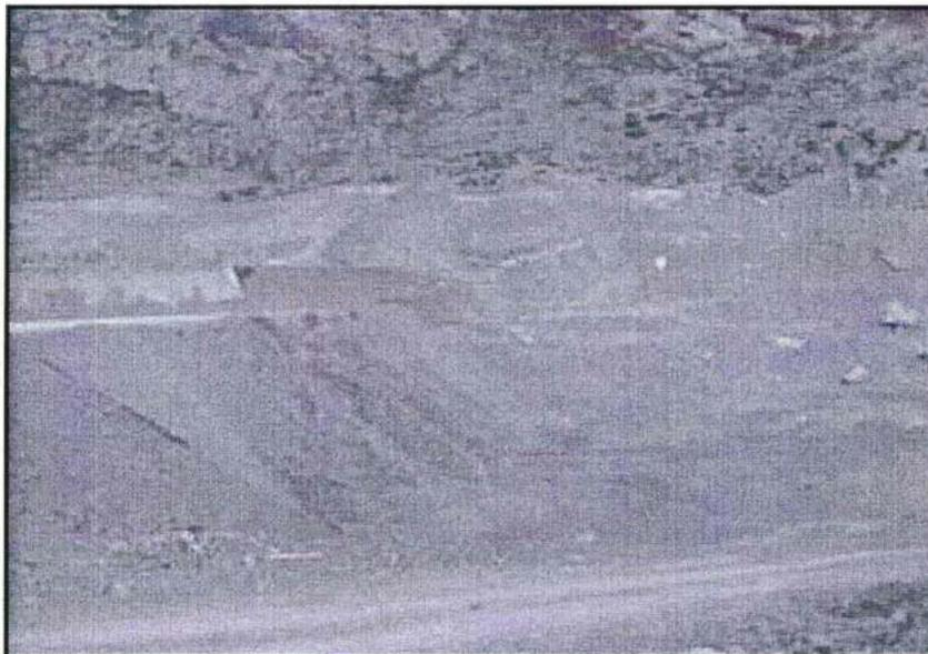
Foto N° 29: Vista del depósito de desmontes Huantajalla con las rumas de desmonte en dirección de la laguna Añilcocha sin instalaciones de protección para agua de escorrentía y drenaje.
