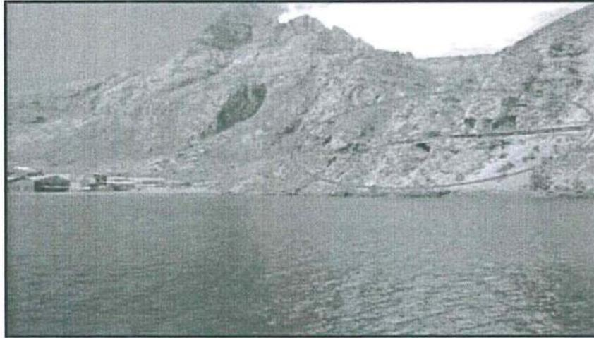
Foto N° 39: Tuberías de conducción de relave desde la planta de procesos pasando sobre el borde de la laguna Colquicocha sin protección para contingencias (Observación N° 6).
