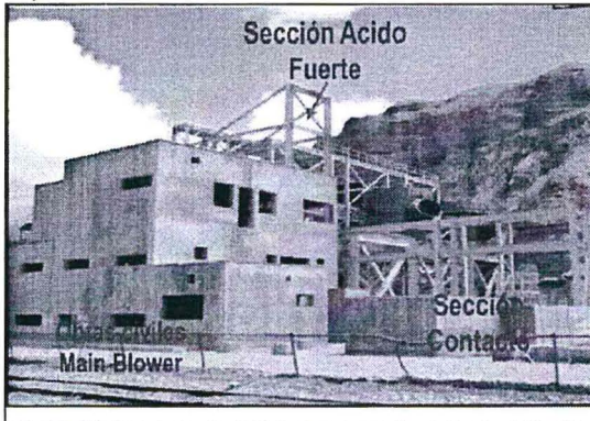
FOTOGRAFÍA N° 30-A.- Sección ácido fuerte y obras civiles del circuito eléctrico: Foto tomada del reporte colgado en la página web de OSINERGMIN (Seguimiento de proyectos 2010). En donde se verificó que la construcción de la referida Infraestructura se encontraba paralizada. Fecha de la verificación: 20 de enero de 2010.
