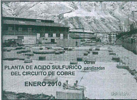
FOTOGRAFIA Nº 27-A.- Precipitador electrostático húmedo: Foto tomada del reporte colgado en la página web de (Seguimiento de proyectos 2010) OSINERGMIN en donde se aprecia que las actividades de construcción se encuentran paralizadas. Fecha de verificación: 20 de enero de 2010.
