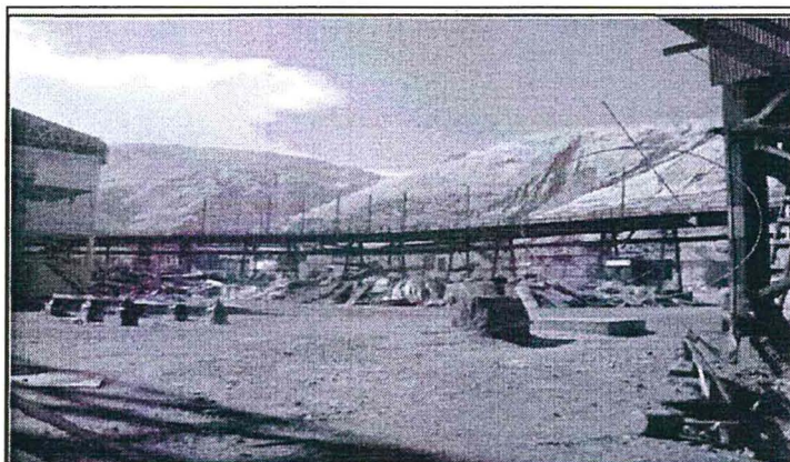
FOTOGRAFÍA N° 25.- Manejo de polvos y gases – Precipitador electrostático: La vista muestra el área donde se instalará el precipitador electrostático. Las actividades se encuentran paralizadas desde el 15 de diciembre de 2008 (según verificación de OSINERGMIN). Fecha de verificación: 23 de agosto de 2012.
