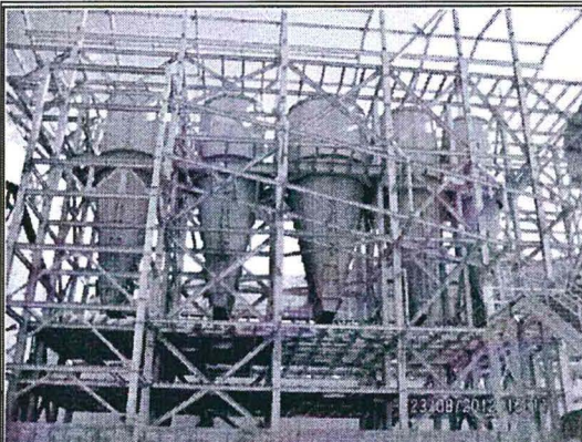
FOTOGRAFÍA N° 13.- Tolvas de almacenamiento: Otra vista de la instalación de las 5 tolvas de almacenamiento, las cuales aún faltan concluir con la instalación de los demás componentes o accesorios. Fecha de verificación: 23 de agosto de 2012.
