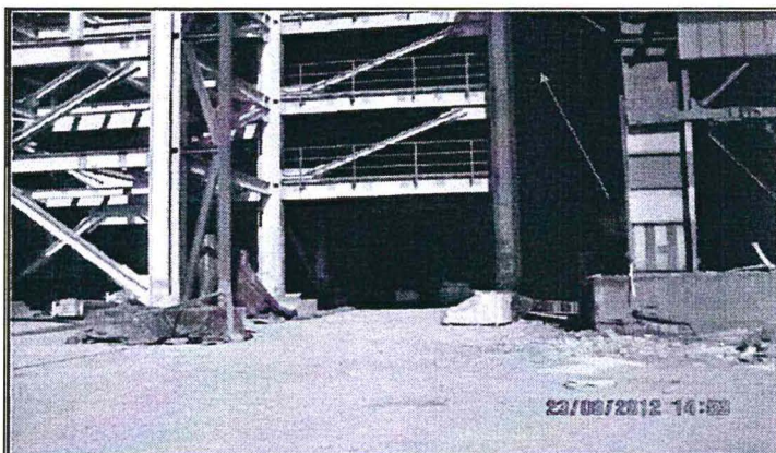
FOTOGRAFÍA N° 26.- Servicios complementarios: La vista muestra el área donde se instalarían los servicios complementarios (Abastecimiento de fuerza, aire, vapor, oxígeno y agua). Las actividades se encuentran paralizadas desde el 15 de diciembre de 2008 (según reporte de supervisión de OSINERGMIN). Fecha de verificación: 23 de agosto de 2012.
