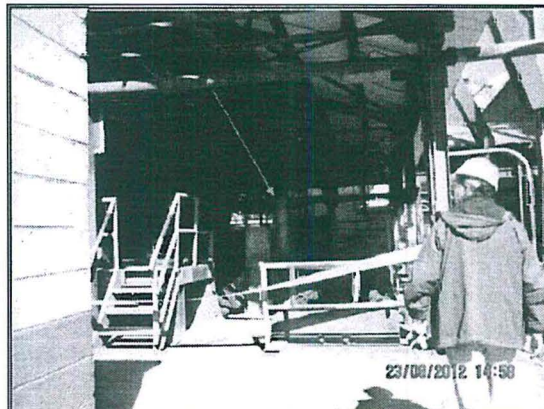
FOTOGRAFÍA N° 22.- Área de Moldeo y Horno Refino: La vista muestra el área de moldeo del circuito de cobre, en el cual se implementaría el Horno refino del Proyecto. actividades de construcción paralizadas. Fecha de verificación: 23 de agosto de 2012.
