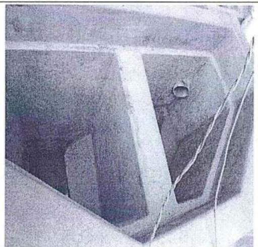
Foto N° 23: Implementación de infraestructura para proceso de almacenamiento y recirculación de agua de curtiembre: "Pozas de decantación".
