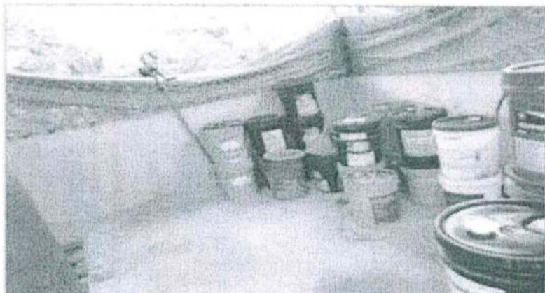
Foto N°34: Vistas al interior del almacén de combustible, no se aprecia sistema de drenaje o contención en caso de derrames
