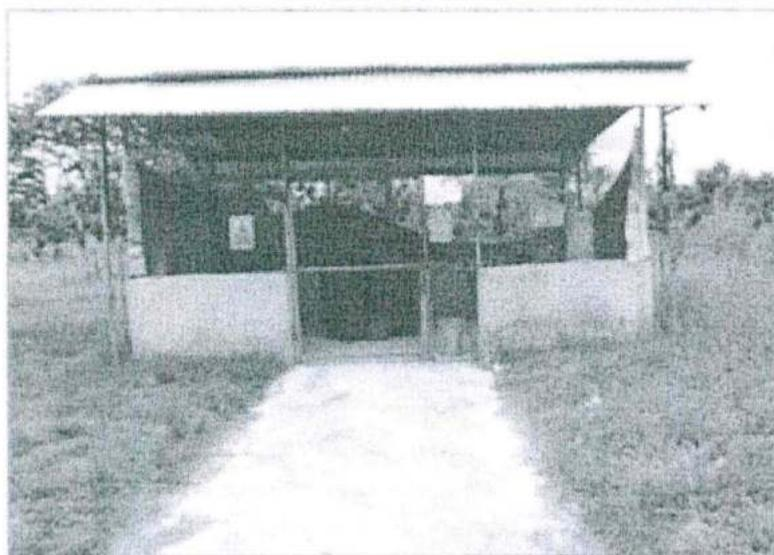
Foto N°33: Vista externa del almacén de combustible, nótese la puerta de ingreso sin dique de contención en caso de derrame
