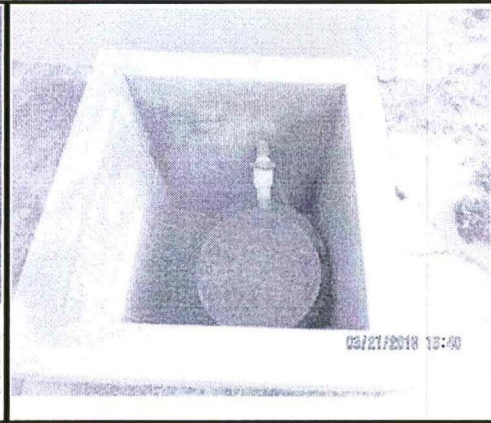
2. Sistema de contención y almacenamiento, con tanque de plástico de 250 l de capacidad conectado con un tubo de PVC de 2 pulgadas de diámetro hasta el interior del almacén de residuos peligrosos en la poza de contención del sistema de drenaje con una válvula que se puede regular. Este tanque se encuentra dentro de una poza de contención de 1.3x1.3x1.05 m cerrada herméticamente con tapa hecha de plancha de hierro para que no ingrese agua del exterior o lluvias.
