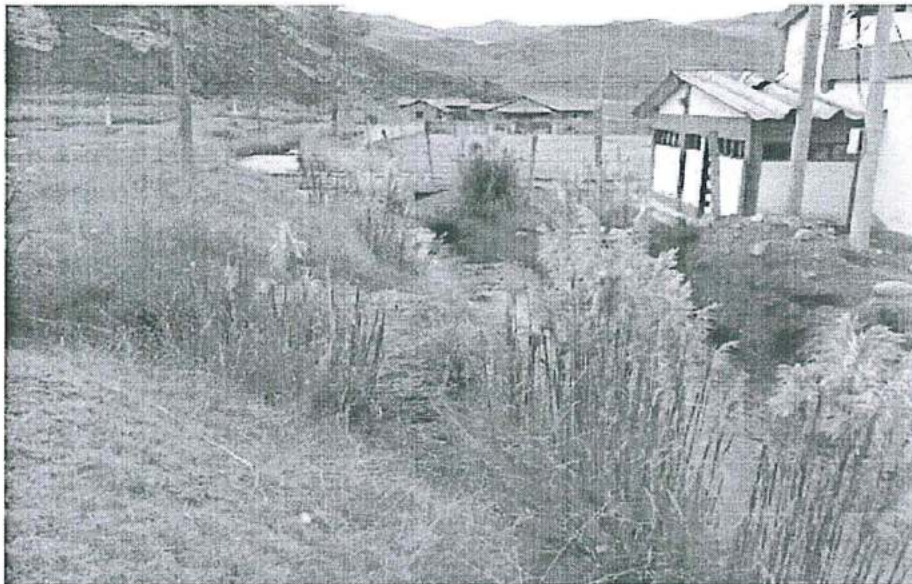
Foto N° 27 Vista de la salida de los efluentes provenientes de los estanques del centro de cultivo. No se observa las pozas de decantación y sedimentación para el tratamiento de los efluentes.
