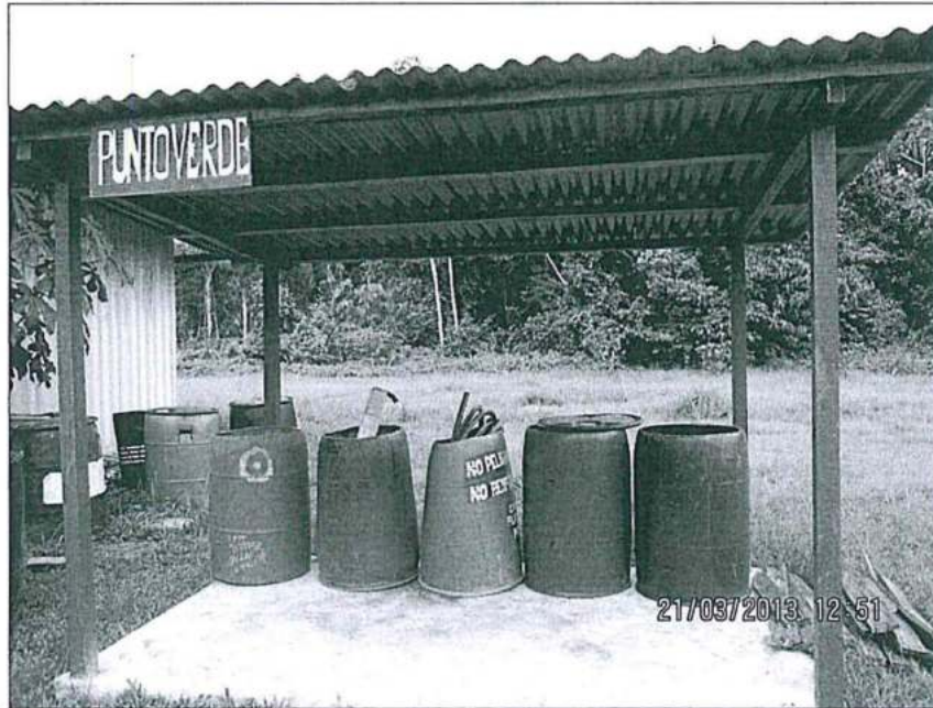
FOTOGRAFÍA N° 6.- En el Punto Verde de la batería 8 se observó que los contenedores no tienen tapa y el rotulado que indique el tipo de residuos que contiene.
