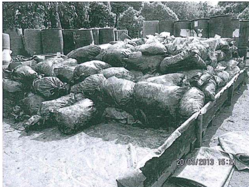
FOTOGRAFÍA N° 4: En el patio de borras, se observó bolsas plásticas conteniendo material impregnado de hidrocarburos, dispuestas sobre una bandeja con geomembrana y en un ambiente abierto.
