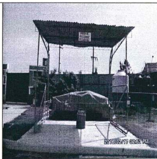
Fotografía N° 4: Vista del área de residuos peligrosos.
