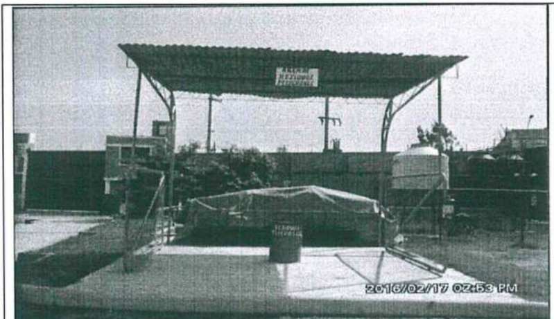
Fotografía N° 4: Vista del almacén de residuos peligrosos (señalizado, rotulado, techado)
