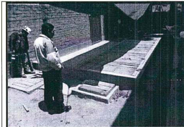
Foto N° 14: Vista de la poza de sedimentación donde llegan los efluentes industriales de la Planta Arequipa.
