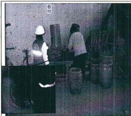
Foto N° 21: Vista de almacenamiento de aceite residual en cilindros de metal dispuestos al costado de los residuos no peligrosos, sin un
