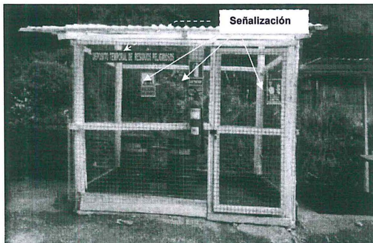
Fotografía N° 5: Vista de la señalización del DTRP
