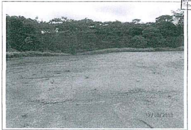
Fotografía N° 25: Locación del Pozo CN 05 (Coordenadas UTM Sistema WGS 84: 0334295E, 9702436N). Obsérvese, que la empresa ha retirado los suelos impactados con hidrocarburos y los demás residuos no peligrosos del área.
