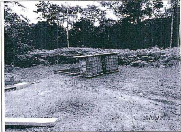
Fotografía N° 34: Jibaro Extensión 1 – Sumidero (Coordenadas UTM Sistema WGS 84: 0381644E, 9701429N) se observó dos build drums conteniendo suelos impactados con hidrocarburos almacenados en un área sin impermeabilizar
