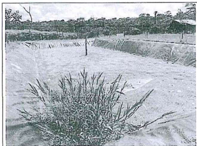
Fotografía N° 42: Relleno Sanitario de Residuos Orgánicos (Coordenadas UTM, Sistema WGS 84: 0375806E, 9719362N y 0375802E, 9719378N), cuyas celdas (dos) que no cumple con las disposiciones técnicas del Artículo N°85 del D.S. N° 057-2004-PCM.
