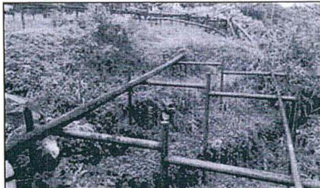
Control de erosión mediante conformación de terrazas.
