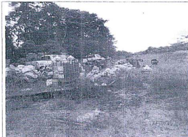
Fotografía N° 24: Camino del Pozo CN 07. Se verificó que la empresa ha retirado los residuos peligrosos. Sin embargo, tiene pendiente disponer adecuadamente los residuos de chatarra y concreto y cemento solidificado.
