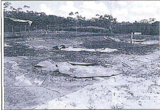
Fotografía N° 41: Relleno Sanitario de Residuos Orgánicos (Coordenadas UTM, Sistema WGS 84: 0375806E, 9719362N y 0375802E, 9719378N), cuyas celdas (dos) que no cumple con las disposiciones técnicas del Artículo N°85 del D.S. N° 057-2004-PCM.
