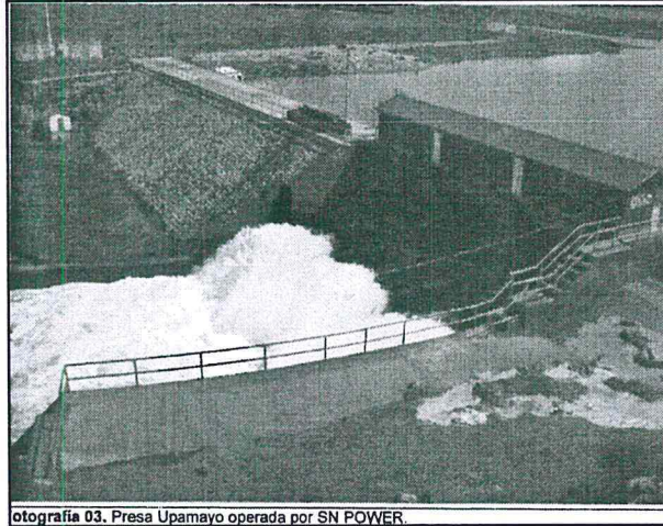
Fotografía 03. Presa Upamayo operada por SN POWER.
