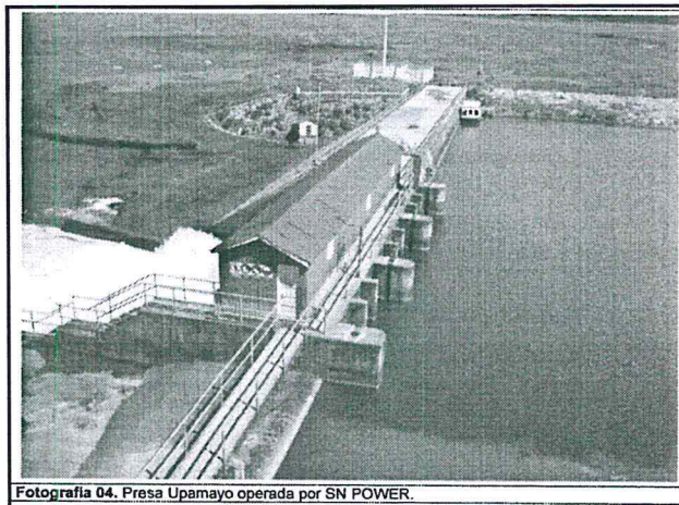
Fotografía 04. Presa Upamayo operada por SN POWER.
