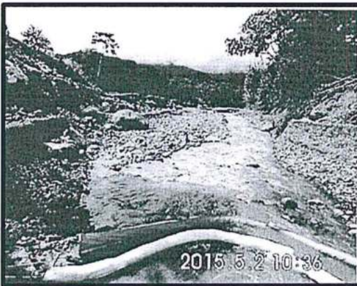
Foto N° 20: Quebrada Kintipiri Zona de control 19 A de acuerdo al Plan de Contingencias. Detalle de la instalación de barrera de contención y chorizo oleofilias con el objeto de recuperar el LGN sobre el cuerpo de agua. Coordenada UTM sistema WGS84: 0658512E, 8570915N
