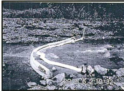
Foto N° 22: Quebrada Kintipiri Zona de control 19 A de acuerdo al Plan de Contingencias. Detalle de la instalación de barrera de contención y chorizo oleofilias con el objeto de recuperar el LGN sobre el cuerpo de agua. Coordenada UTM sistema WGS84: 0658512E, 8570915N
