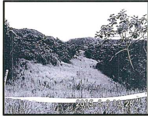
Foto N° 05: KP 185+644 hacia mayores (Flujo hacia Pisco) Se observa la pendiente del DDV. Foto tomada desde las coordenada UTM, WGS84: 0656041E, 8570198N
