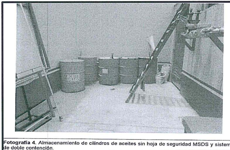
Fotografía 4. Almacenamiento de cilindros de aceites sin hoja de seguridad MSDS y sistema de doble contención.
