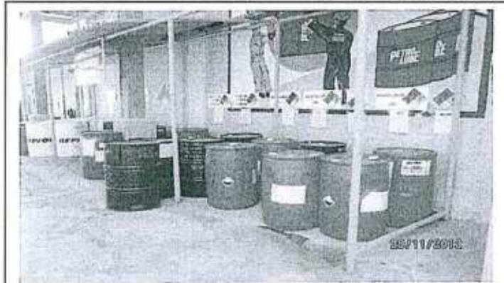
Fotografía N° 18: Se muestra el área donde se viene almacenando productos químicos y combustibles, sobre un área que no cuenta con barrera de doble contención.
