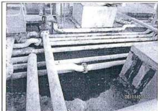
Fotografía N° 7: Se muestra el área de manifold de tuberías en la cual se puede apreciar presencia de suelo contaminado con hidrocarburos, aproximadamente 20 m 2 .
