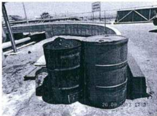
En la Planta Lastre, al lado de las bombas P603 y P604, se evidenció 01 cilindro de solvente que se encontraba dispuesto sobre el suelo y sin sistema de doble contención.
