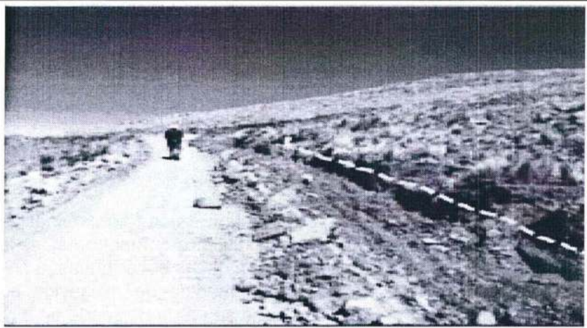
Foto 10: Tramo de la cuneta de drenaje para el acceso a niveles.
