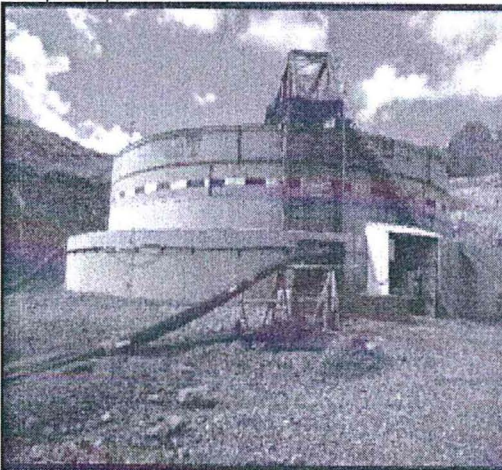
Tuberías en la salida del Tanque Espesador a relavera.
