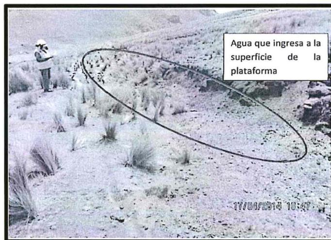
**Fotografía N° 3:** Plataforma de perforación JADD12-02 cerrada sin perfilar y revegetada parcialmente, obsérvese que las aguas de escorrentías ingresan a la superficie de dicha plataforma formando charcos
