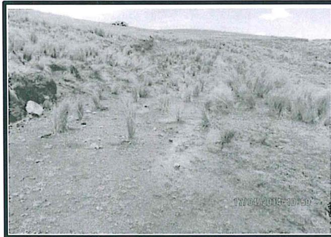
**Fotografía N° 4:** Plataforma de perforación JADD12-02 cerrada sin perfilar y revegetada parcialmente, obsérvese que las aguas de escorrentías ingresan a la superficie de dicha plataforma formando charcos.
