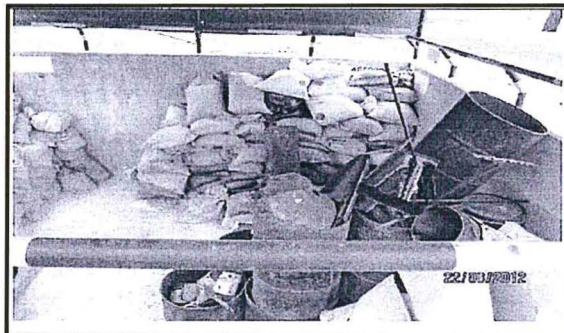
Fotografía N° 3: Recipientes de residuos sólidos no identifican el tipo de residuos.
