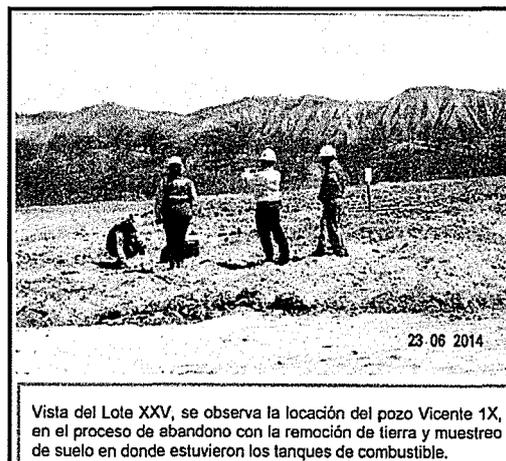
Vista del Lote XXV, se observa la locación del pozo Vicente 1X, en el proceso de abandono con la remoción de tierra y muestreo de suelo en donde estuvieron los tanques de combustible.
