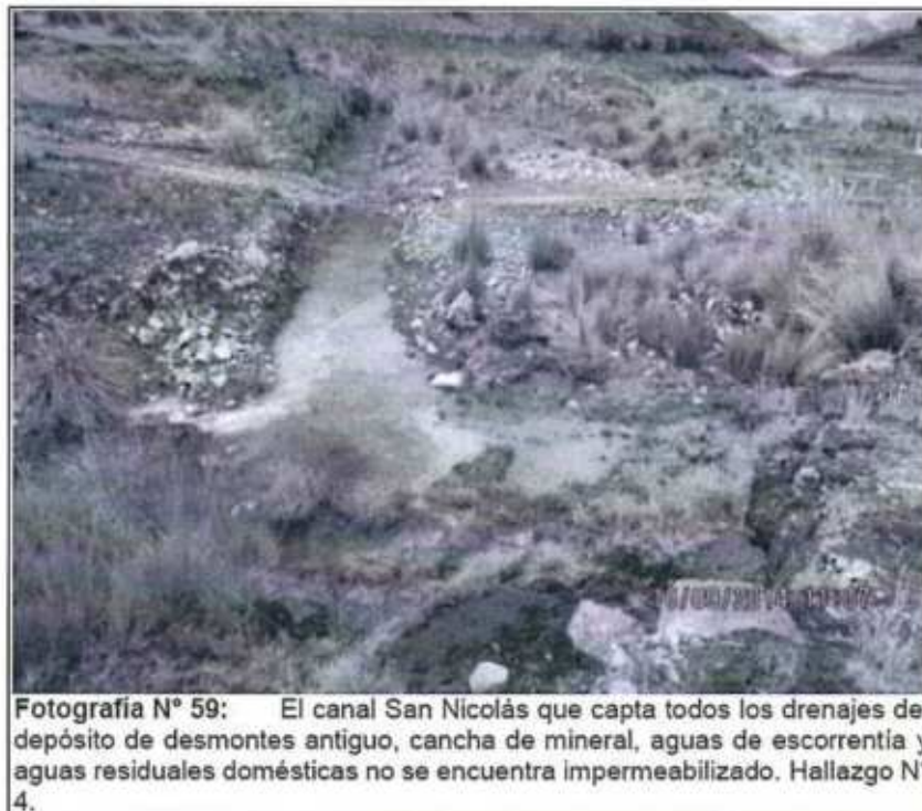
Fotografía N° 58: Canal San Nicolás que funciona como canal de captación de escorrentías, drenajes y subdrenajes para el depósito de desmontes antiguo. Hallazgo N° 4.
