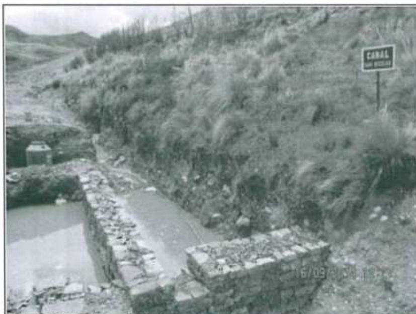
Fotografía N° 21: Vista fotográfica de sedimentadores en construcción en terreno natural sin impermeabilizar del canal San Nicolás que se utiliza como canal de coronación del depósito de relaves. El efluente es conducido a la Planta de tratamiento Renacimiento.
