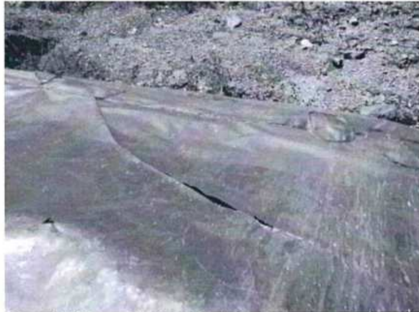
Fotografía N° 51: Vista fotográfica de la roturas en la geomembrana del pad de lixiviación. El pad de lixiviación, las pozas de solución barren y de grandes eventos en la zona de San Nicolás no cuentan con piezómetros para el control de aguas subterráneas. Adicionalmente se encontraron roturas en la geomembrana en algunos sectores en el borde del pad. Hallazgo N° 11.
