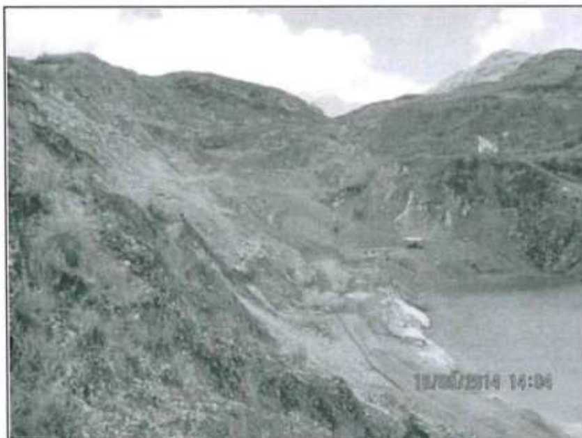
Fotografía N° 31: Vista del tajo El Zorro, poza en terreno natural sin impermeabilizar para la recepción de drenajes, tampoco se nota la existencia de piezómetros para el control de agua subterránea. Hallazgo N° 8 y 9.
