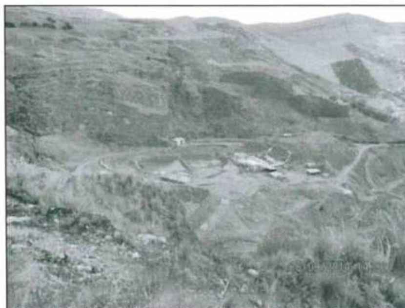
Fotografía N° 35: El tajo El Zorro no tiene canal de coronación diseñado ni ejecutado. Tampoco cuenta con piezómetros para el control de aguas subterráneas. Hallazgo N° 9.
