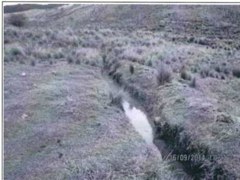
Fotografía N° 58: Canal San Nicolás que funciona como canal de captación de escorrentías, drenajes y subdrenajes para el depósito de desmontes antiguo. Hallazgo N° 4.
