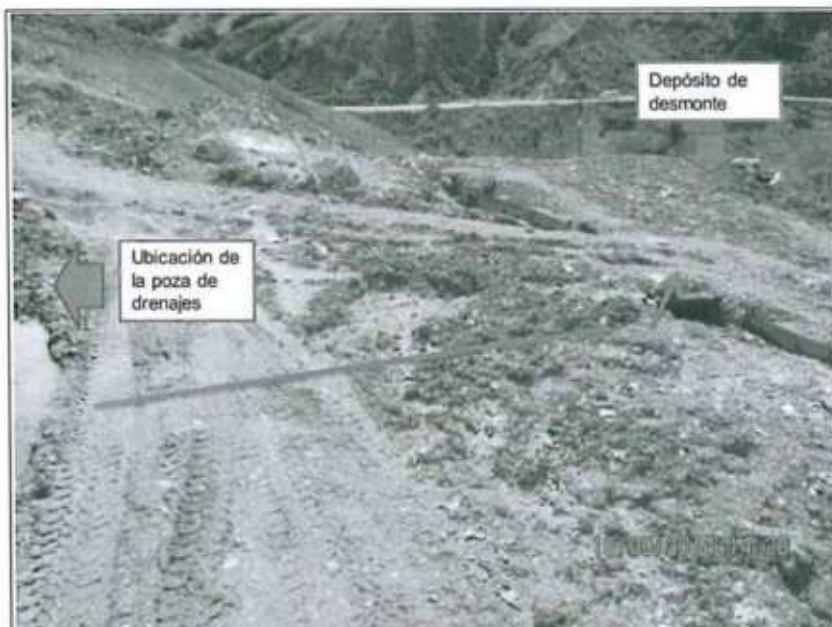
Fotografía N° 181: El tajo El Zorro cuenta con una poza para la acumulación de drenajes en terreno natural, dicha poza presenta filtraciones que discurren hacia el depósito de desmontes en la parte inferior del tajo. Hallazgo N° 8.
