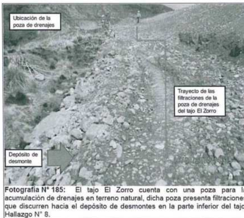
Fotografía N° 181: El tajo El Zorro cuenta con una poza para la acumulación de drenajes en terreno natural, dicha poza presenta filtraciones que discurren hacia el depósito de desmontes en la parte inferior del tajo. Hallazgo N° 8.
