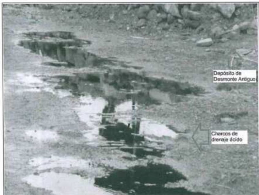
Fotografía N° 68: El depósito de desmontes antiguo presenta charcos de drenaje ácido con un pH < 1 al pie junto al canal de coronación, no cuenta con canal de captación de drenajes, los efluentes de dichos charcos ingresan al dicho canal el cuál es de terreno natural. Hallazgo N° 1.
