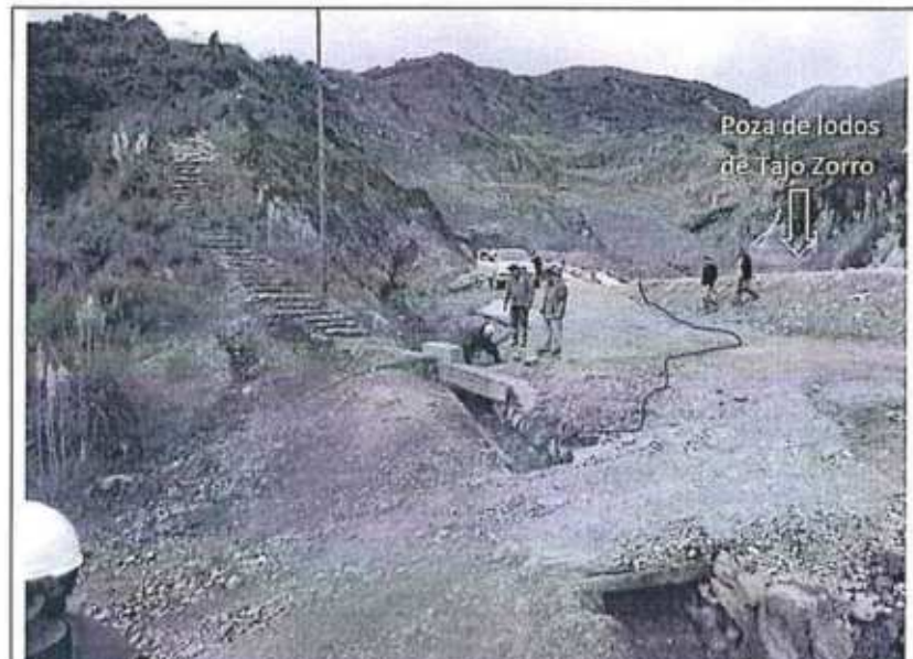
Fotografía N° 31. Hallazgo N° 2.- Se evidencia que las aguas de la poza de lodos están derivándose hasta un canal adyacente el que descarga al Río Tingo.
