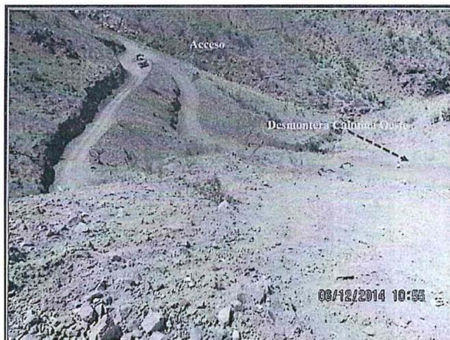
Fotografía N° 20: Hallazgo N° 1, Supervisión Regular Diciembre 2014, Se observó que se han construido vías de accesos al área proyectada a la desmontera Cahuiña Oeste. Coordenadas de referencia WGS84 N 8500242, E 454281.
