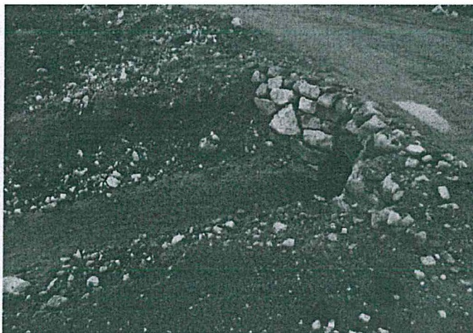
Foto N° 02: Después habilitación de alcantarilla.
