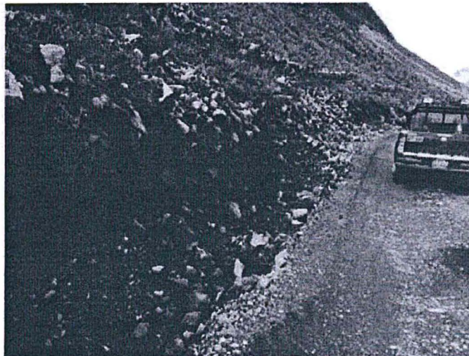
Foto N° 11: Vista durante fiscalización
