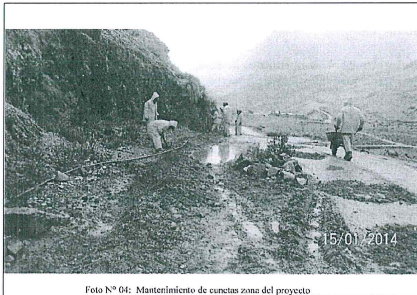
Foto N° 04: Mantenimiento de cunetas zona del proyecto
