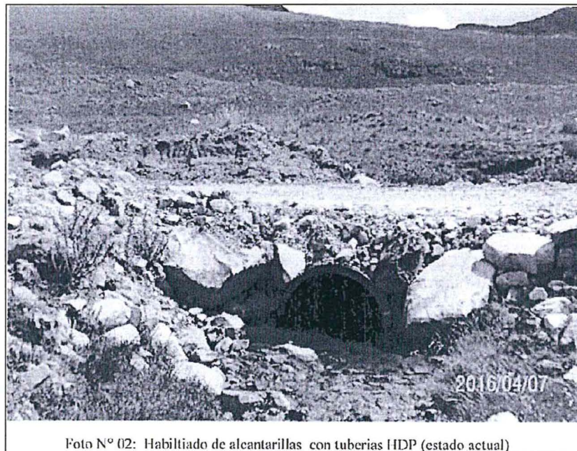
Foto N° 02: Habilitado de alcantarillas con tuberías HDP (estado actual)
