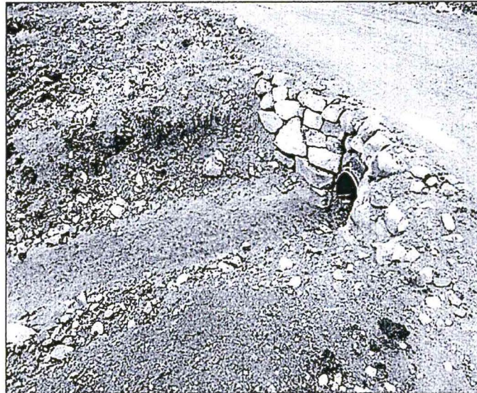
Foto N° 02: Habilitado de alcantarillas con tuberías HDP (estado actual)
