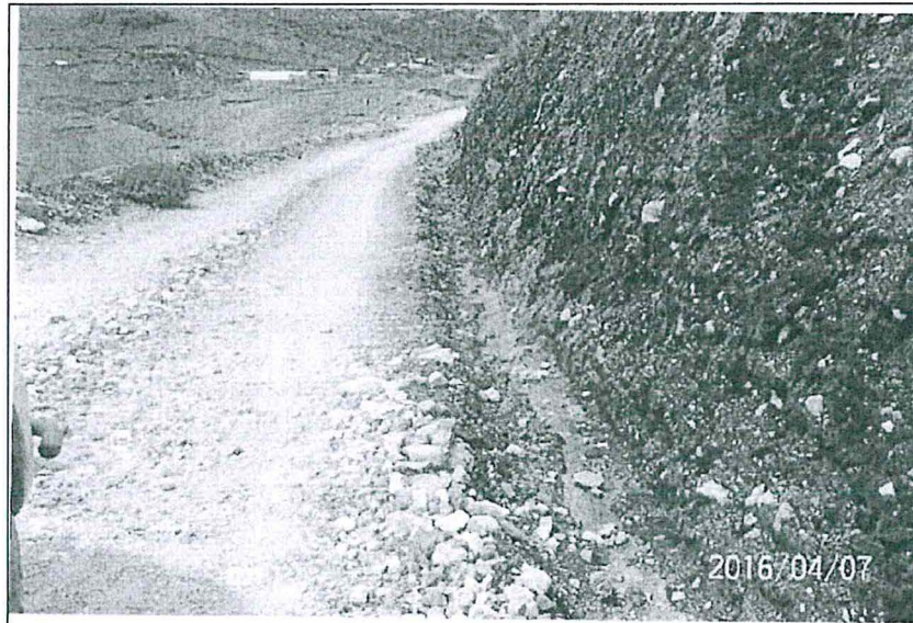
Foto N° 01: Vías de acceso en el campamento con infraestructura hidráulica (estado actual)
