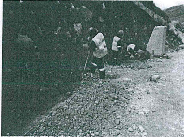
Foto N° 12: Mantenimiento de cunetas en las zonas afectadas.
