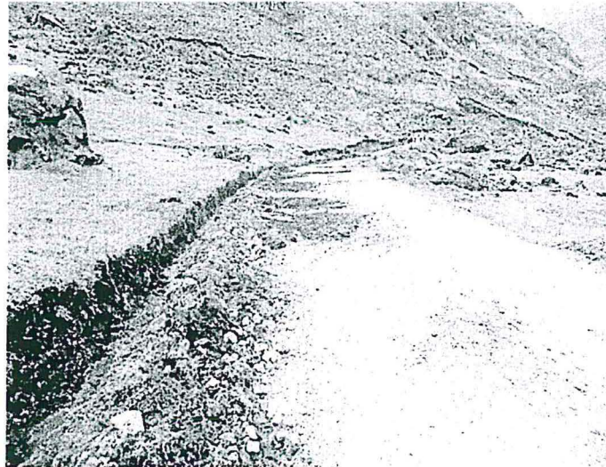
Foto N° 04: Mantenimiento de cunetas en los accesos existentes (Estado actual)
