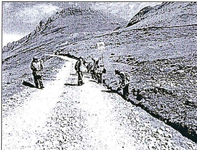
Foto N° 06: Mantenimiento de cunetas en el sector Huacchara.
