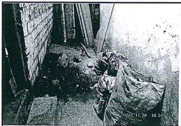
FOTO N° 16: Punto de Acopio de Residuos Sólidos Se observa el acopio inadecuado de residuos peligrosos, tales como envases plásticos con pintura, los cuales se encuentra dentro de un ambiente cerrado. Coordenadas UTM (WGS84), Zona 18 672284N, 0268367E.
