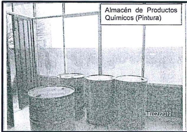
Fotografía N° 7: El almacén de cilindros de pintura no cuenta con suelo impermeabilizado y carece de sistema de doble contención
