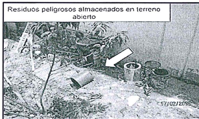
Fotografía N° 5: Residuos peligrosos como envases vacíos de pintura se encontraban en terrenos abiertos
