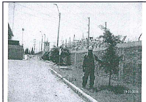
Foto N° 02.- Lado derecho (central) del perímetro de la C. T. Independencia
