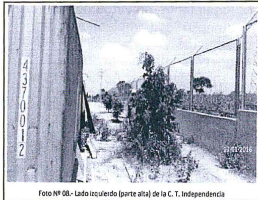
Foto N° 08.- Lado izquierdo (parte alta) de la C. T. Independencia
