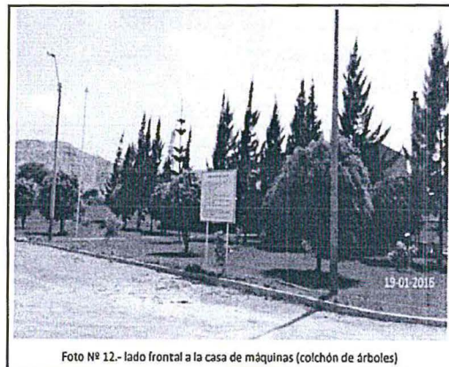
Foto N° 12.- lado frontal a la casa de máquinas (colchón de árboles)
