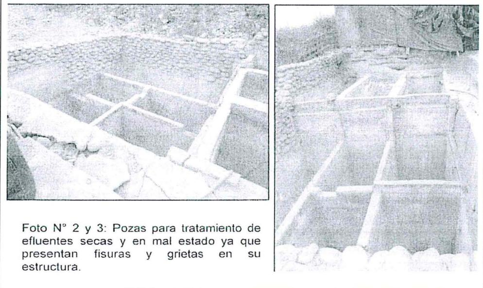
Foto N° 2 y 3: Pozas para tratamiento de efluentes secas y en mal estado ya que presentan fisuras y grietas en su estructura.
