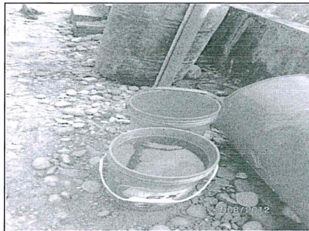
Fotografía N° 7.- En el Puesto de Venta de Combustible – Grifo INAMBARI, de propiedad de Lucio Quispe Hualla se observó balde de plástico abierto (sin tapa), conteniendo hidrocarburos, debiendo haber sido recolectado y depositado en recipiente cerrado.
