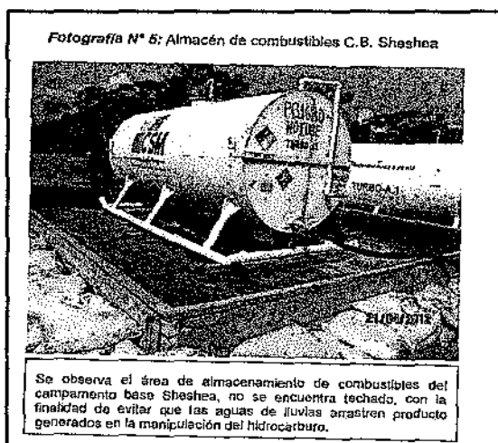
Fotografía N° 5 del Informe de Supervisión N° 829
