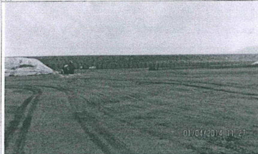
Foto N° 11: Se aprecia parte de las pilas/rumas de carbón coberturada con mantas o toldos (a) así como la superficie del terreno afirmado con remanentes de carbón (b) que son regados con el apoyo de camiones cisterna (c) para reducir el arrastre del material particulado sin embargo se observa en la parte posterior del almacén impregnación de material particulado a la altura de los depósito (pilas/rumas) de carbón (d).
