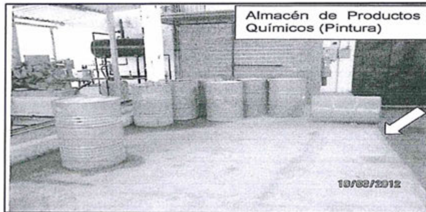
Fotografía N° 6: El almacén de cilindros de pintura no se encuentra en suelo impermeabilizado y con doble contención
