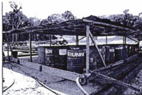
Fotografía N° 4: Almacén de residuos líquidos peligrosos. Sheshea 1X
