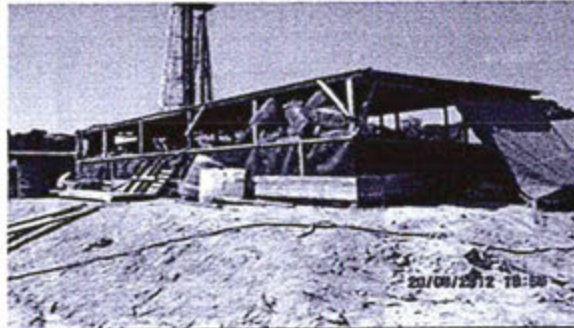
Fotografía N° 3: Almacén de residuos peligrosos. Sheshea 1X
