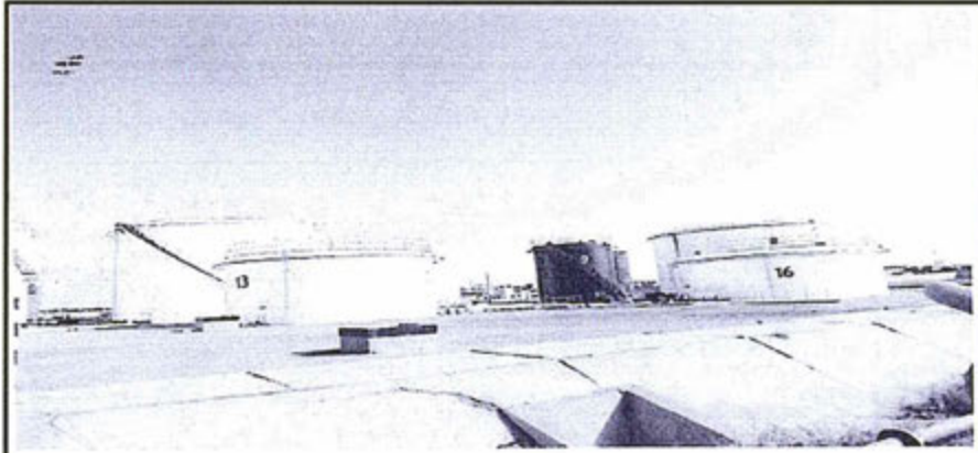
Fotografía N° 5: Área estancia 1 sin impermeabilizar. Se observan los tanques N° 8, 9, 13, 16
