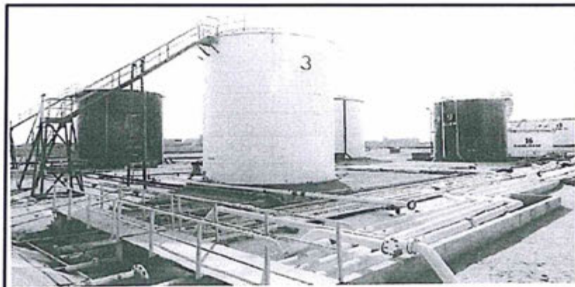
Fotografía N° 3: Área estancia 1 sin impermeabilizar. Se observan dos (02) tanques slop negro y los tanques N° 3, 16 y del área estancia N° 3, se observa el tanque N° 18
