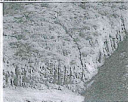
Vista 5. Suelo, con rajaduras longitudinales, encima de la perforación del túnel bocatoma Huaura - bocatoma Checras.
