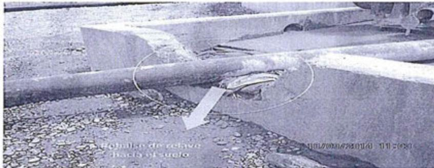
Fotografía N° 35.- Se puede apreciar rebalse de relave sobre el suelo.
