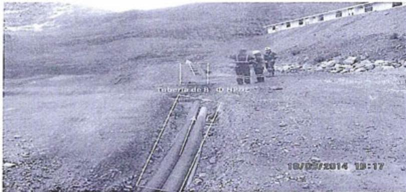
Fotografía N° 30.- Tubería que transporta relaves de la planta concentradora hacia el tanque espesador; las tuberías no disponen de sistema de protección frente a eventualidades en los 420 m lineales de longitud.
