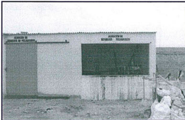
Almacén central de residuos sólidos peligrosos Fuente: Fotografía N° 7 del Informe N° 952-2012-OEFA/DS
