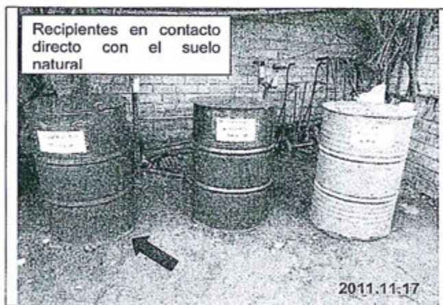
Fotografía N° 2: Cilindros para residuos sólidos se encuentran en contacto directo con el suelo natural, y no cuenta con la infraestructura adecuada
