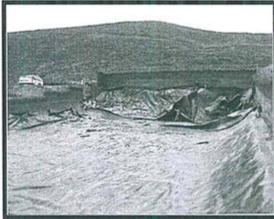
Cobertura del suelo en el relleno sanitario.
