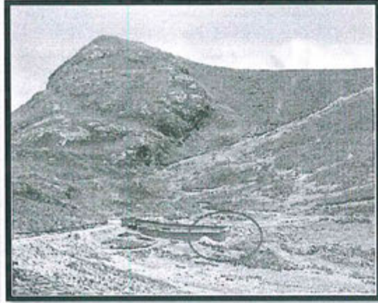
Vista panorámica del Relleno Sanitario con material de cantera para la cobertura de los residuos.
