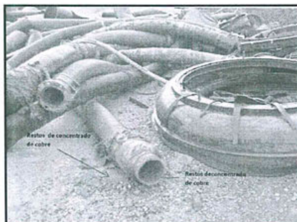
Foto N° 88: Observación N° 10-2012. En el depósito de chatarras, se encontró tuberías procedentes de la planta concentradora, con restos de concentrado de cobre.
