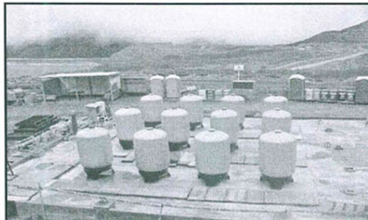
Foto N° 92: Observación N° 12-2012. Otra vista de la planta de tratamiento de aguas contigua a la planta concentradora que el titular minero viene construyendo sin autorización del Ministerio de Energía y Minas.
