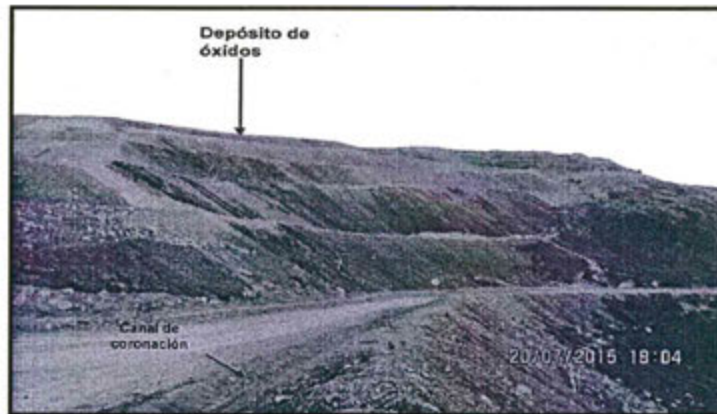
Fotografía N° 7: Cumplimiento de la observación del hecho imputado N° 1 de la supervisión regular 2012. Vista fotográfica del canal de coronación de la parte baja del depósito de óxidos N° 1.
