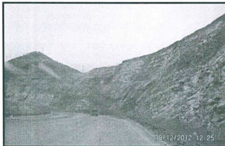
Foto N° 58: Cumplimiento parcial de recomendación N° 8-2011.- Sector de la vía de acceso del Haul Road sin cunetas y/o sin mantenimiento para conducir las escorrentías dentro del área industrial.
