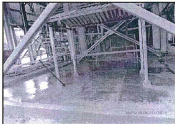
Fotografía N° 9: En la parte baja de la faja de retorno del molino SAG se construyó una losa de concreto armado con canal con rejilla metálica, como parte de un sistema de contención ante posibles derrames de mineral (Cumplimiento de la Recomendación N° 2-2012).
