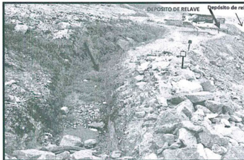
Foto N° 57: Cumplimiento de recomendación N° 8-2011.- Canal para escorrentía con cauce limpio contigua al acceso hacia el dique del depósito de relaves.
