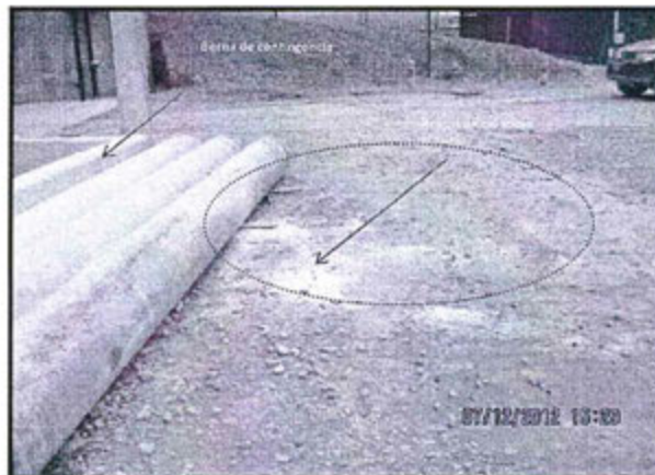
Foto N° 82: Observación N° 06-2012. Se verificó, restos de cal en el entorno de la tolva de recepción.
