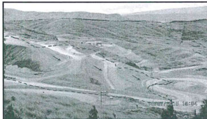
Fotografía N° 4: Cumplimiento de la observación del hecho imputado N° 1 de la supervisión regular 2012. Vista fotográfica del depósito de óxidos N° 1, en la cual se observan las vías de accesos. Coordenadas UTM – Datum WGS 84 N: 9 252 152, E: 762 371 (Zona 17). Las flechas rojas indican las cunetas de las vías de acceso.
