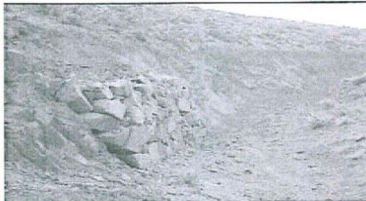
Fotografía N° 8. Limpieza y refuerzo con muro seco de piedra que sirve para estabilizar y evitar posteriores derrumbes en el canal de coronación.
