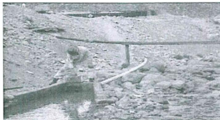
Fotografía N° 18. Sistema de captación y control de agua de ingreso a las pozas de bombeo hacia el reservorio de aguas.
