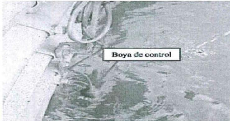
Fotografía N° 16. Sistema de control con boya instalada en el nivel superior del reservorio
