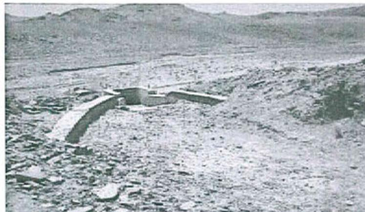
Fotografía N° 9. Construcción de muro de concreto para refuerzo para la captación y entrega de agua de escorrentía punto UTM 18L 0811653 8301854.
