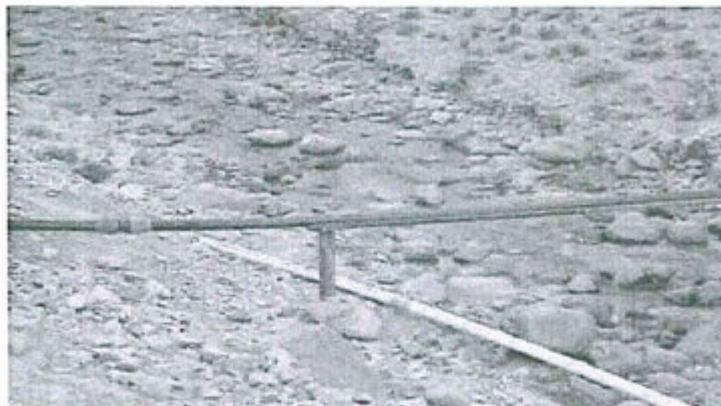
Fotografía N° 17. Tubería de polietileno de 4" para conducción de agua del río Nequeta que pasa sobre río Cacamayo, en donde se observa eliminación de la válvula.
