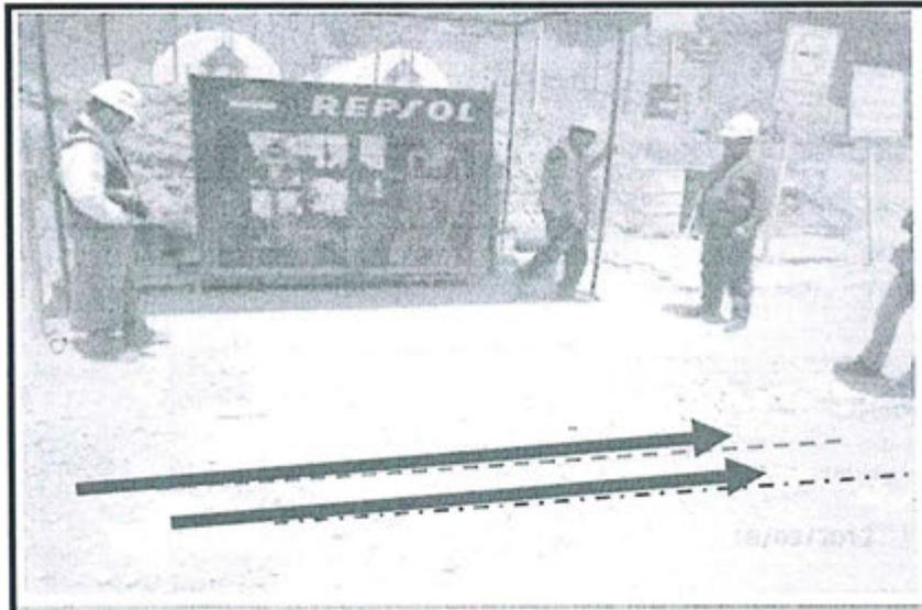
**Fotografía N° 2.-** se observa que la parte de cemento solo cubre parcialmente parte del estacionamiento del tanque cisterna (de combustible). Se observa el límite del piso de cemento (primera flecha) y las huellas que deja el mencionado vehículo (segunda flecha) el cual está fuera del límite del piso de cemento.
