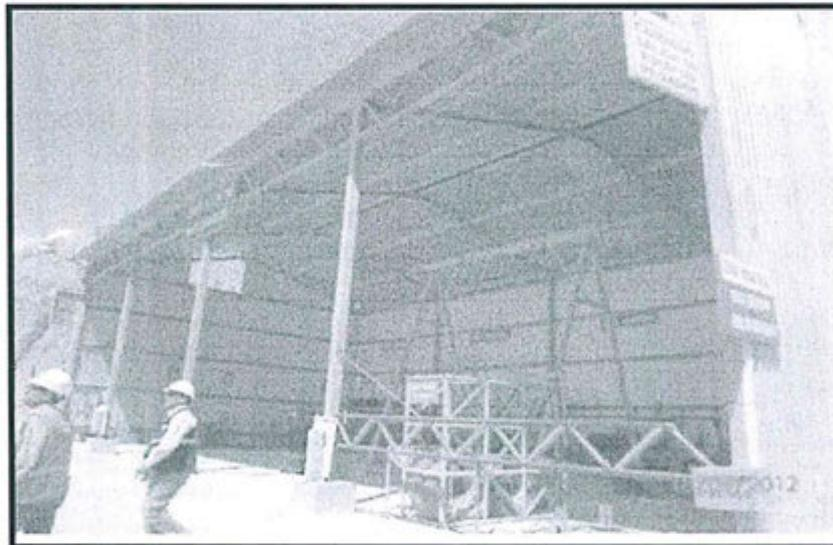
**Fotografía N°4.-** Vista panorámica del Taller de Mantenimiento de vehículos donde se observa que no existe muro de contención o canaleta que permita que las aguas de limpieza discurran antes de llegar al suelo.
