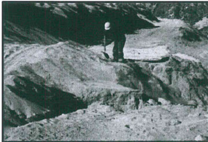
Foto N° 4: Construcción, mejora y mantenimiento de cuentas a lo largo de los accesos en la zona de Yanarico.
