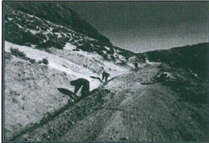
Foto N° 3: Rellenado con piedra y arena de los caminos de acceso a la zona de Yanarico (zona alta y baja).
