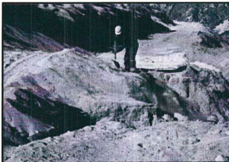
Foto N° 4: Construcción, mejora y mantenimiento de cunetas a lo largo de los accesos en la zona de Yanarico.
