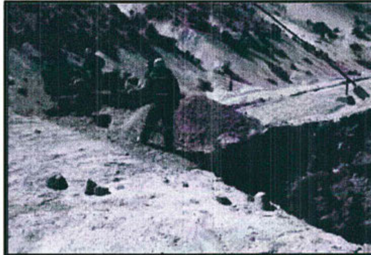
Foto N° 1: Relleno con piedra y arena de los caminos de acceso a la zona de Yanarico (zona alta y baja).
