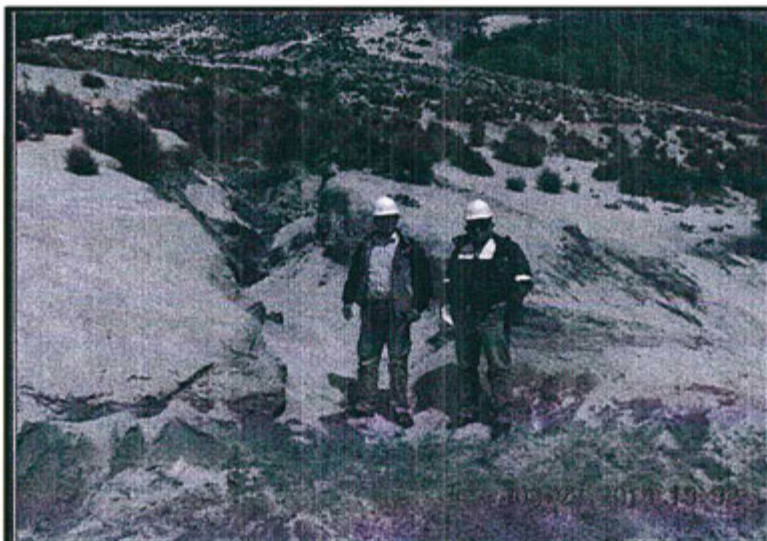
Fotografía N° 2: Erosión en cárcavas en los caminos de acceso a la zona de Yanarico (Zona alta y baja), donde se muestra el inadecuado control de escorrentía debido a la falta de implementación de cuentas. Hallazgo N° 1 – Supervisión Ambiental 2013
