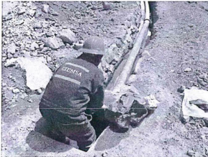
Foto N° 02: Colocación del tapón con plásticos por personal de CIEMSA en la conexión hacia el canal que conducía el efluente (Observación N° 1).
