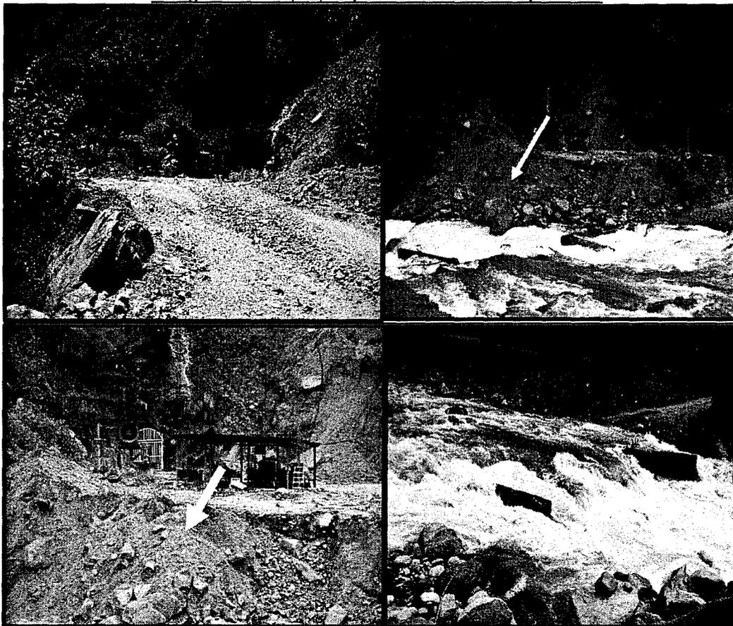
Vista 5. Se observa material que se colocó junto al río como relleno, originando reducción del cauce del río y erosión del mismo. Además se aprecia el badén socavado y cubierto por la crecida del cauce del río Uchubamba.
