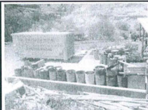
Vista 23. Almacén Central de Mirahuay Bajo.
