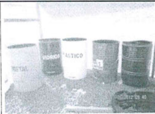
Vista 19. Otro punto de acopio que no cuenta con piso impermeable, ni señalización adecuada. Evidencia de que los puntos de acopio no están implementados completamente.
