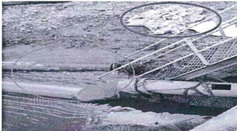
Fotografía 23: Bolsas que almacenan el material derramado en la ribera y cauce del río Huallaga, (residuos peligrosos) identificándose que no tienen un adecuado manejo y disposición de los residuos sólidos peligrosos.
