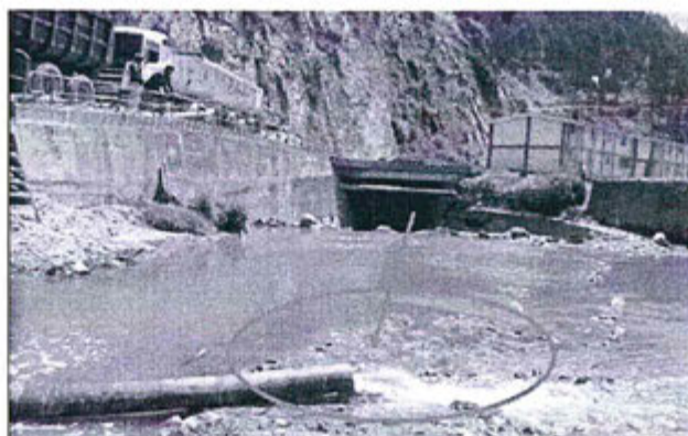
Fotografía N° 04: Vista del efluente minero metalúrgico (E-09) - accidente ambiental de agua clarificada mezclada con sedimentos (Lodos del proceso de sedimentación), personal de la Dirección de Supervisión del OEFA, supervisando el muestreo de agua y sedimentos en el río Huallaga.
