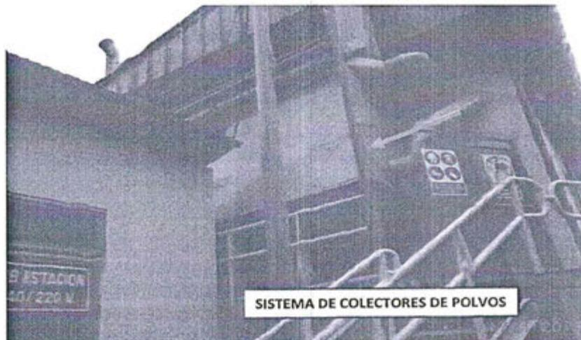
Fotografía VR N° 6: En el laboratorio químico se instaló sistemas de recuperación de polvos y vapores, a fin de evitar que afecten negativamente a la calidad de la atmósfera.
